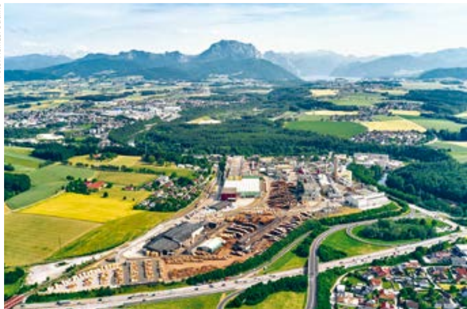
Die beiden Heinzel-Werke Steyrermühl (vorn) und Laakirchen (hinten) werden mit einer Dampfleitung verbunden und können in einem effizienten Energieverbund arbeiten.
