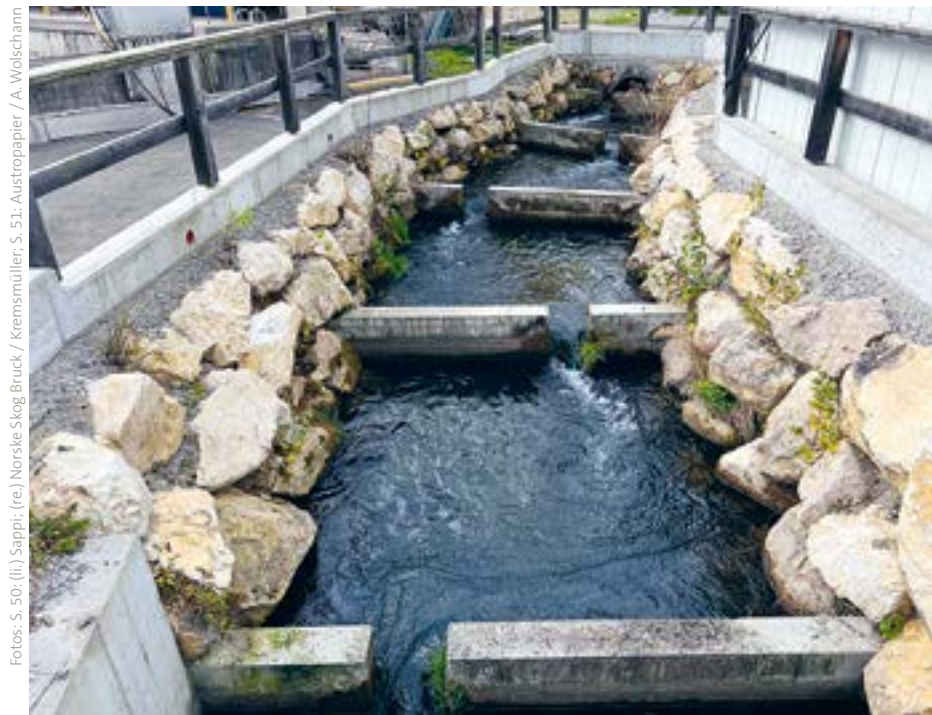
Schonender Umgang mit Flora und Fauna: Eine Fischtreppe ermöglicht den Flussbewohnern eine ungehinderte Wanderung entlang der Gewässer.
